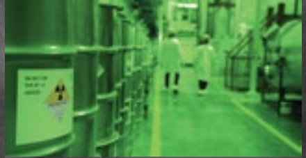
Nakladanie s rádioaktívnym odpadom
